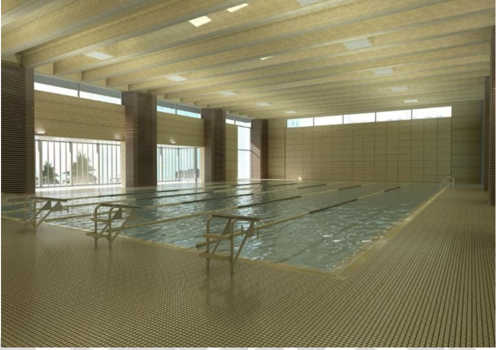
Bilkent Üniversitesi Yüzme Havuzunda Ardgerme Uygulanmış Kiriş (21 metre açıklık 80 cm kiriş ile geçilmiştir.)
