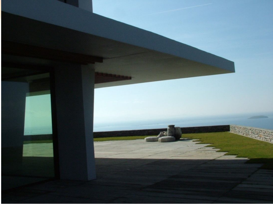
Canyon Range Kartalyuvası Çift Taraflı Konsol Uygulaması (6 metre konsol 30 cm döşeme)
